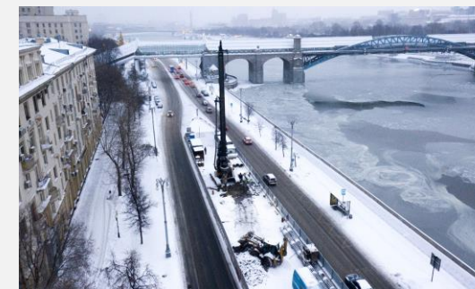
Реконструкция газопроводов-дюкеров
