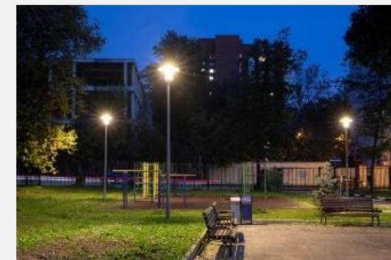
Устройство наружного освещения по адресу: Ленинградский проспект, д. 46 (ГБОУ «Школа № 152»)
