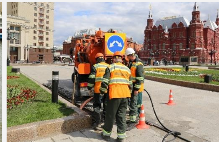
Промывка водосточных сетей
